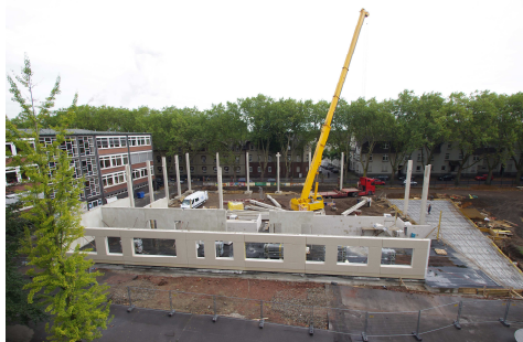
Zur Zeit der Grundsteinlegung.
